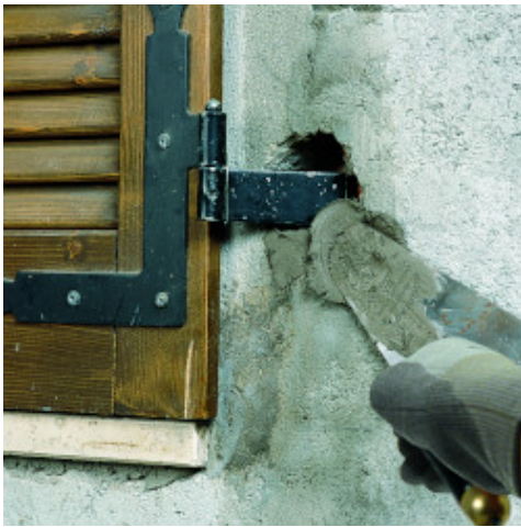
Τοποθέτηση αγκυρίων για παράθυρα με Lamprocem
