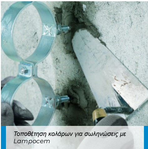
Στερέωση κουτιών και σωληνών για ηλεκτρικές εγκαταστάσεις με Lamprocem
